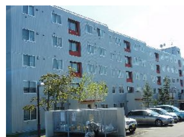
Wing12 (築12年 62戸) 2011年外断熱改修
