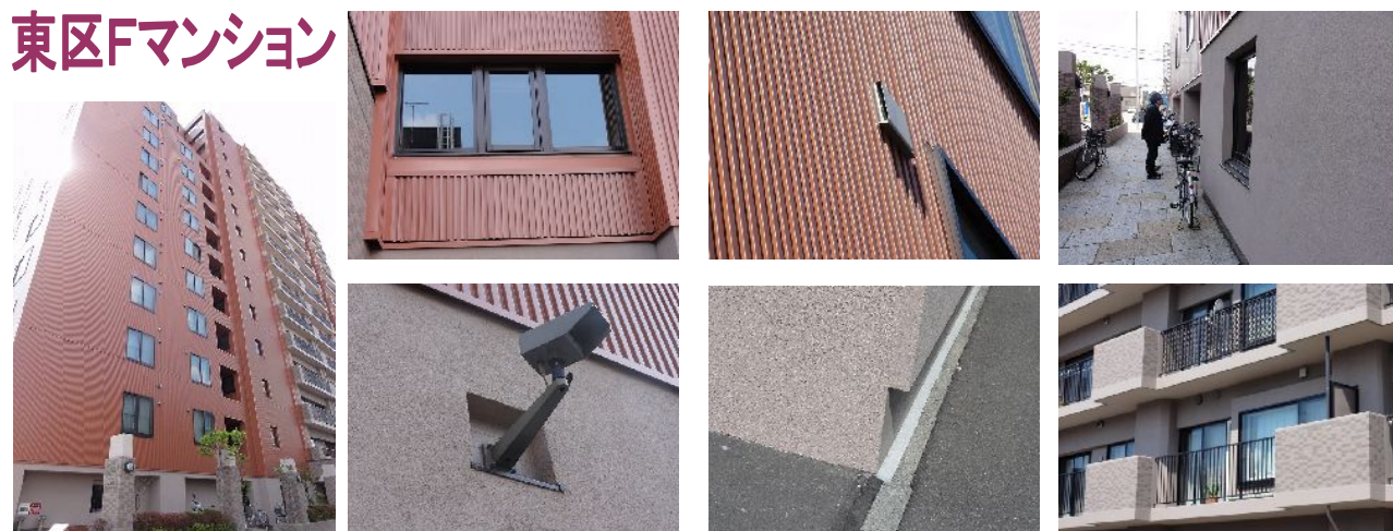
1997年竣工SRC造14階建て 61戸 2010年改修工事 乾式工法 断熱材ESPボード t50mm 外壁はガルバリウム鋼板 t0.4mm
