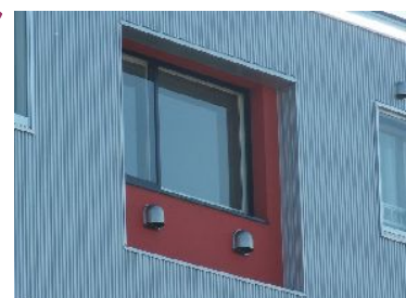
Wing12 (築12年 62戸) 2011年外断熱改修
