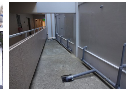
写真上) ドライエリアの排水 管の新設
