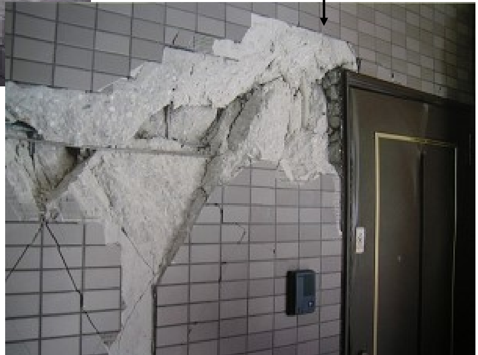
雑壁が破損し、住戸内が覗ける
